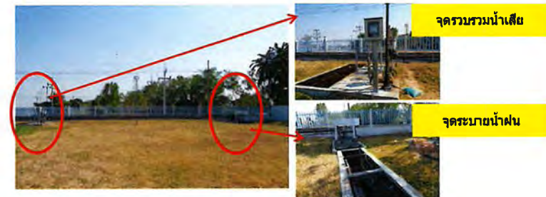
ระบบระบายน้ำเสีย แยกจากระบบระบายน้ำฝน
