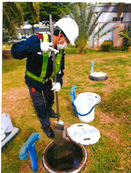
ระบบบำบัดน้ำเสีย (บ่อบำบัดอากาศมี 3 บ่อ , เดิม EM)
